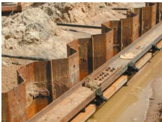
Figur 14. Exempel på traditionell spont med hammarband och horisontella stag. Bildkälla: Arcelormittal.com.
