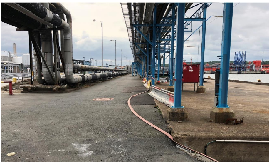
Figur 6. Bild över Kustkajen med hög rörbrygga på innersta delen av kajkonstruktionen till höger. Till vänster den låga rörbryggan som löper parallellt med kajen och vidare ut på Sprängstenspir.
